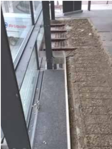
Für Manufactum in Hannover wurde die Galerie mit speziellen Stahlfasen geschlossen und somit der Verkaufsbereich erweitert. Die Decke schließt bündig mit den bodentiefen Fenstern ab.
