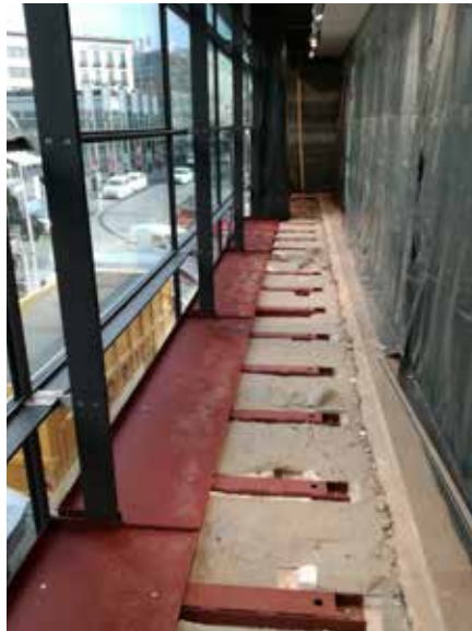
Für Manufactum in Hannover wurde die Galerie mit speziellen Stahlfasen geschlossen und somit der Verkaufsbereich erweitert. Die Decke schließt bündig mit den bodentiefen Fenstern ab.
